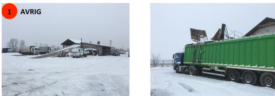
Figură 2-8 - Stația de transfer și compostare Avrig
