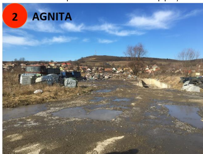
Figură 2-10 - Stația de transfer Agnita
